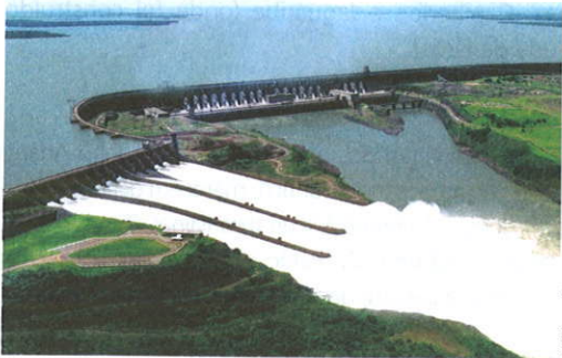
Hidrelétrica de Itaipu
